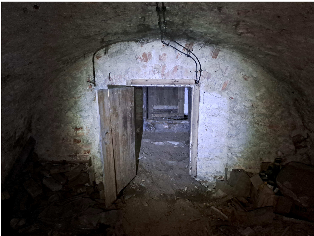
Fot. nr c2 (widok wtórnego zamurowania z drzwiami na wewnętrznym licu muru)
