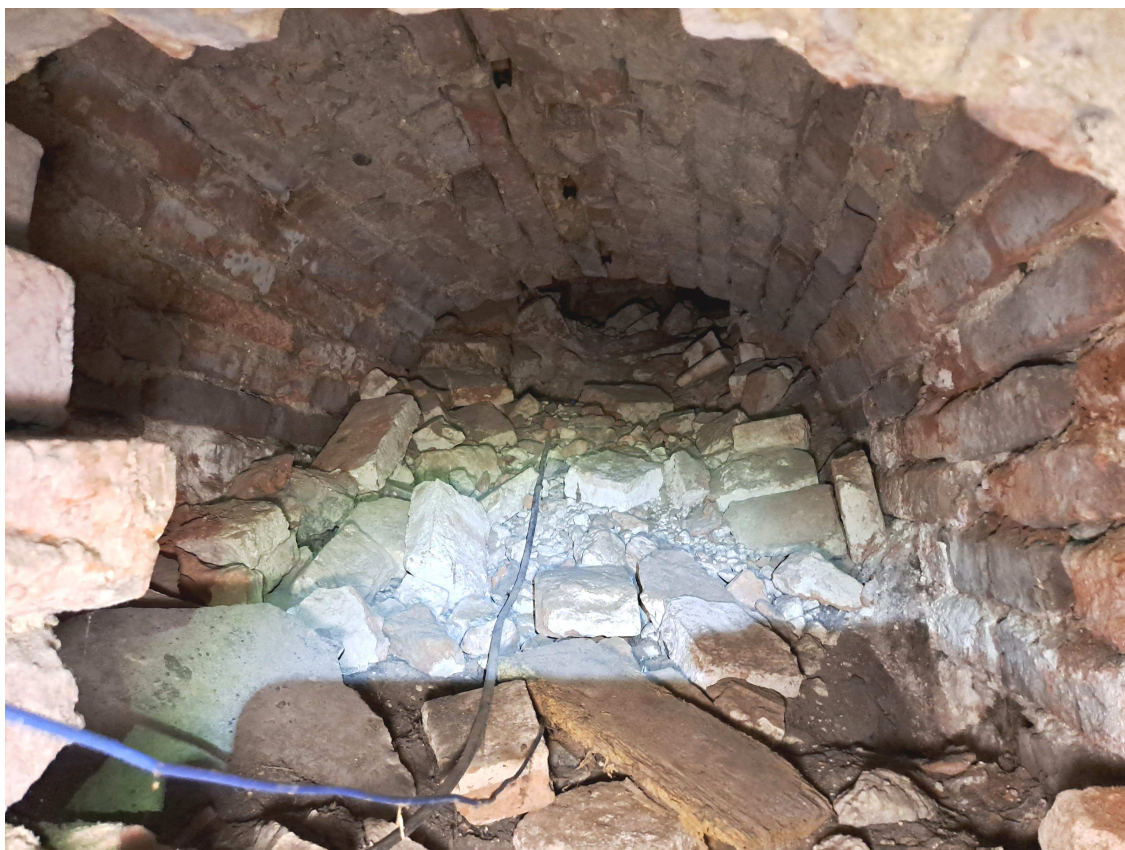
Fot. nr d2 (widok rumoszu poniżej sklepienia nad wejściem do wieży)
